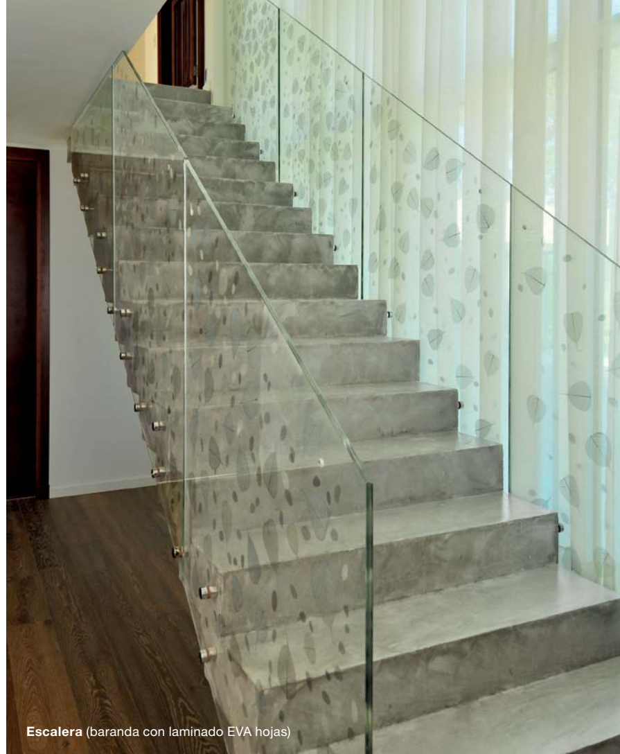
Hilton Montevideo Shopping (solución estructural de barandas y pisos con cristales laminados templados)
