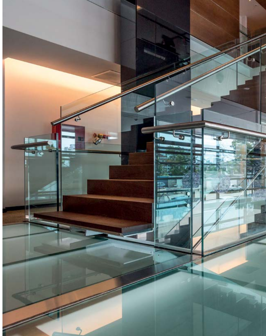
Hampton by Hilton (baranda estructural laminada con SentryGlas)
