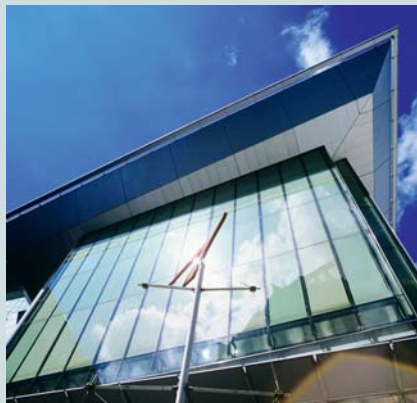
Imagen 11. Los paneles de la costosa fachada de vidrio de la entrada al centro comercial Citygate, que está situado cerca del aeropuerto de Hong Kong, tienen que reemplazarse continuamente ya que los cantos de los vidrios usados previamente con intercalarios de PVB muestran signos de deterioro a los cinco años. Los paneles de SIGLAPLUS® VSG de FLACHGLAS Wernberg que fueron instalados hace ya más de cuatro años no muestran cambios perceptibles en su apariencia.
