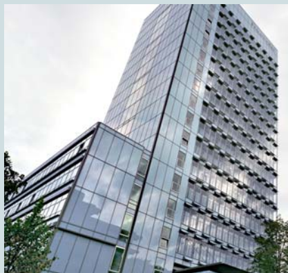
Imagen 12. Al renovar la fachada de vidrio de las oficinas centrales de the Fraunhofer Gesellschaft en Múnich, se reemplazaron los paneles originales de vidrio de seguridad templados por vidrio de seguridad laminado, cuya ventaja en caso de rotura es que los fragmentos permanecen adheridos al intercalario hasta que el panel pueda ser reemplazado. El vidrio de seguridad tradicional laminado con intercalarios de PVB era demasiado pesado para la estructura de apoyo. Sólo la utilización del vidrio de seguridad con el intercalario laminado SentryGlas®, considerablemente más fino y ligero, hizo posible una renovación rentable y sin construcción.
