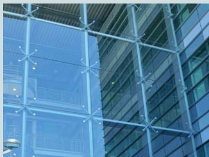
Imagen 3. Paneles de la fachada (derecha de la imagen) por encima del área de entrada al nuevo edificio de oficinas propiedad de Bouygues Imobiliária en Lisboa hecho con el rígido y resistente vidrio de seguridad laminado con el intercalario DuPont™ SentryGlas®. La habilidad del intercalario de proporcionar laminados altamente resistentes con excelentes prestaciones post-rotura ha permitido al especialista en ingeniería de fachadas Facal crear una fachada más fina y ligera que requiere un sistema de fijación menos prominente. Fotos: Facal
