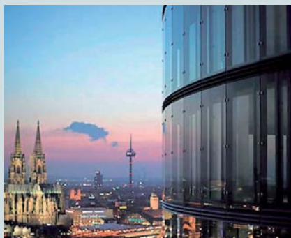
Imagen 5. Una fachada hecha con vidrio laminado hace que la torre 'Cologne Triangle' de 103 m, de altura tenga un aspecto estéticamente transparente. Debido a que los paneles con puntos de sujeción han sido fabricados con intercalarios SentryGlas® estos pueden ser un 20% más delgados que si estuvieran hechos con un vidrio de seguridad laminado con un intercalario de PVB normal, aun así son capaces de resistir fuertes cargas de viento.
